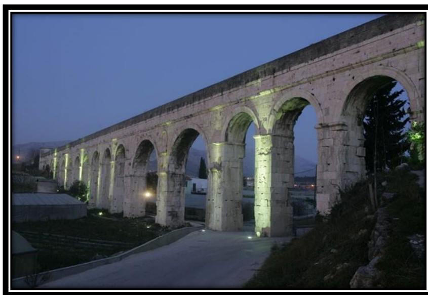
Slika 5.1. Akvadukt Split, preuzeto sa http://www.vik-split.hr/foto-galerija/emodule/616/egallery/1 , 6.6.2018.
